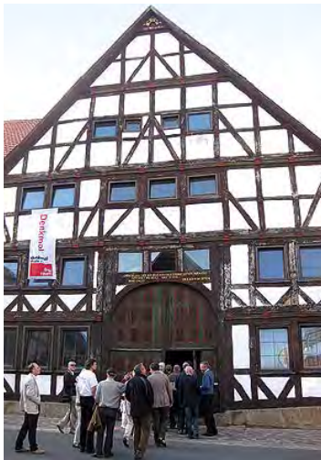
Grebensteiner Bürger gründen als Verein ihre eigene Bauschule. In dieses sanierungsbedürftige Haus soll sie einmal einziehen. Während des Selbstausbaus dient es als praktisches Lehrobjekt.
