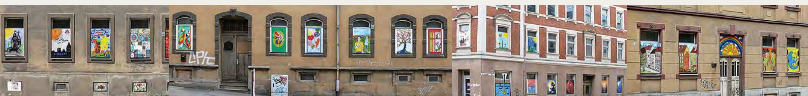
Straßengalerie Chemnitz-Sonnenberg: Sicherungsmaßnahmen können auch Kunstwerke sein.
