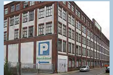
In den Räumen des ehemaligen Industriegebäudes der Stadt Elmshorn soll eine Kulturhalle mit vielen Nutzungen entstehen.
