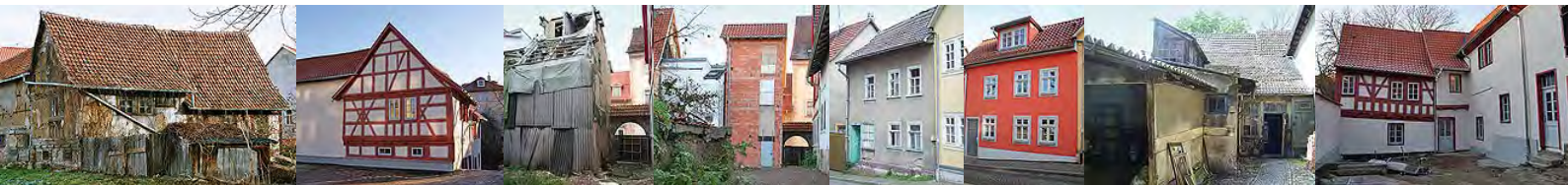
Altbauten in Arnstadt, jeweils vor der Sicherungsmaßnahme (links) und heutiges Erscheinungsbild nach einer Sicherung bzw. Sanierung (rechts).
