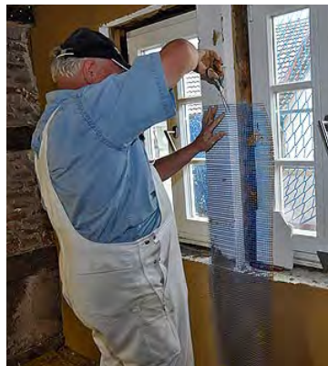
Umnutzung aktiv. Die Wanfrieder Bürger packen selbst mit an, wenn es darum geht, die wertvollen Fachwerkhäuser der Stadt für die Zukunft zu sichern. Hier entstehen Räume, die zukünftig der „Bürgergruppe für den Erhalt der Wanfrieder Häuser“ für Beratung und Öffentlichkeitsarbeit zur Verfügung stehen werden.
