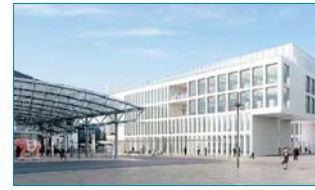
Im Rahmen des Stadtumbaus aktuell ersetzt durch hoch- wertige Neubebauung
